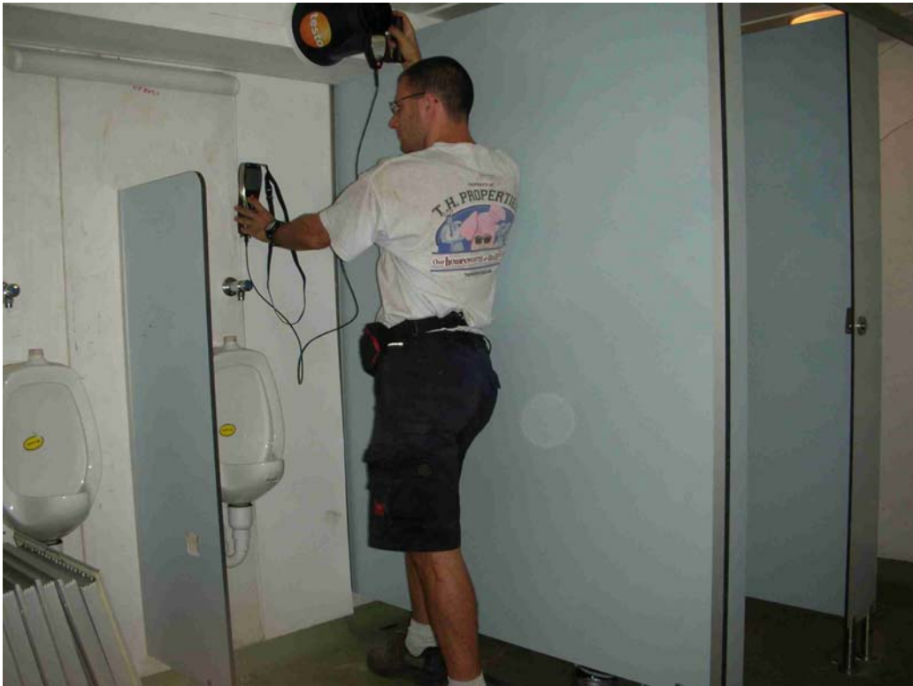
GEORG BEIM EINMESSEN DER WC ABLUFT
