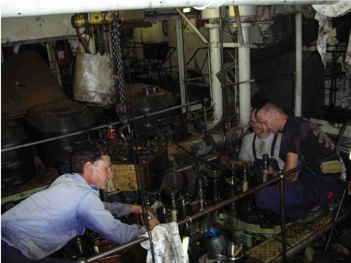
BEIM ZUSAMMENBAU EINES HAUPTANTRIEBES
